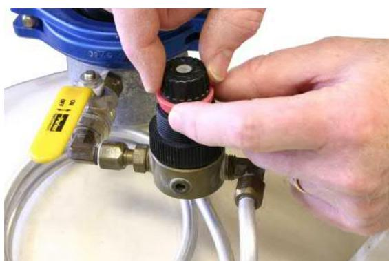
Рисунок 9-2: Красное стопорное кольцо на регуляторе.
